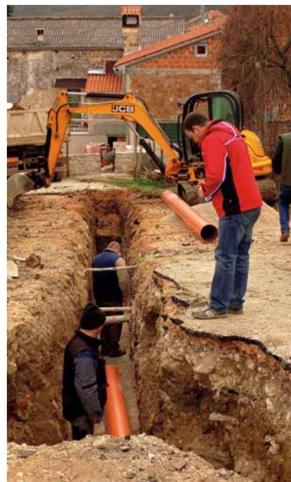
Gore lijevo i sredina: Izgradnja šahtova važan dio sustava, no kameniti je teren otežavao rad strojevima
